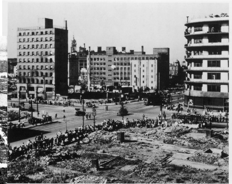
日本橋白木屋百貨店のある交差点。左端のビルが八洲ホテル。すぐ右に見える塔は、三越の屋上のものか（昭和20年9月24日）
